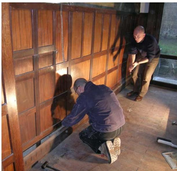
**4. Le démontage des panneaux de lambris du jardin d'hiver a facilité la comparaison avec la technique de construction d'un panneau de lambris original du salon central et la compréhension de leur construction.**
