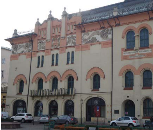
5. Old Theater ( Teatr Stary ) in Cracow, Szczepański Square, facade details, (photo: Elzbieta Przesmycka).
