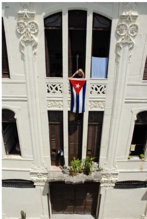
7. Bâtiment Les Pélicans, façade principal (photo : Orlando Inclán)
