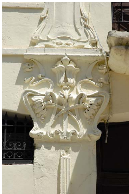
8. Bâtiment Les Pélicans, détail (photo : Orlando Inclán)
