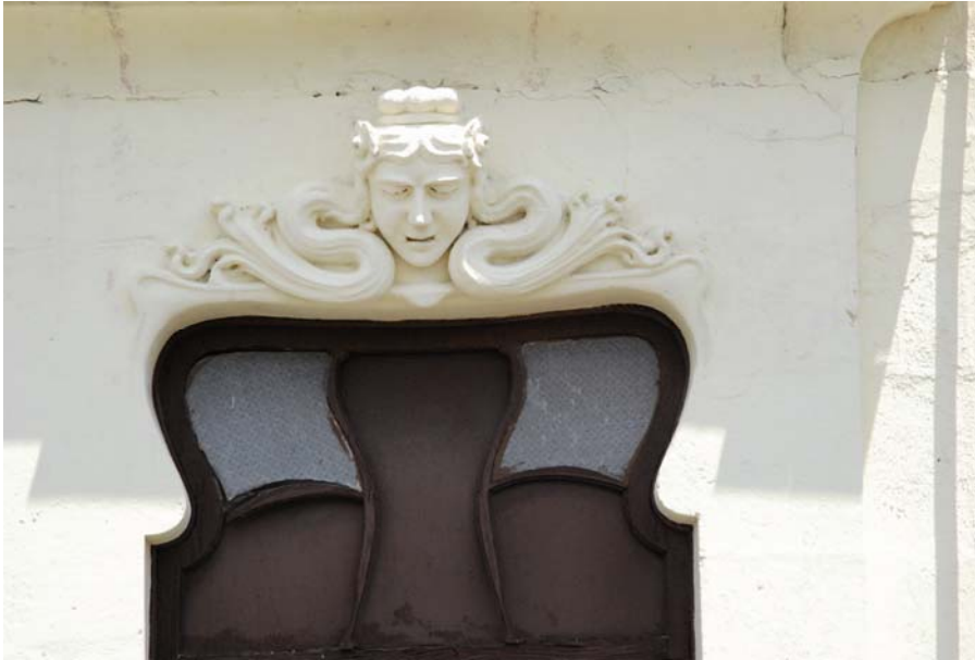
9. Bâtiment Les Pélicans, détail de fenêtre (photo : Orlando Inclán)
