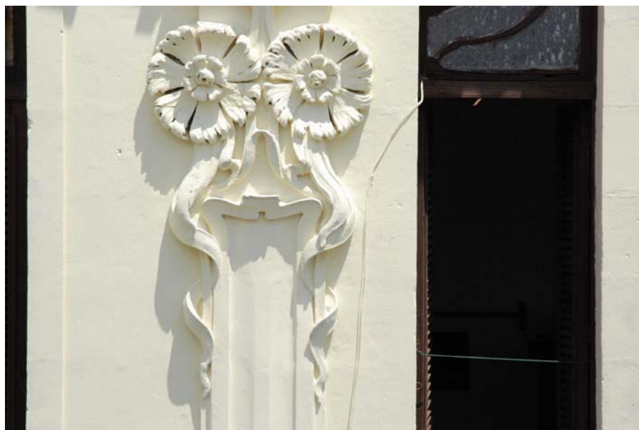
10. Bâtiment Les Pélicans, détail (photo : Orlando Inclán)
