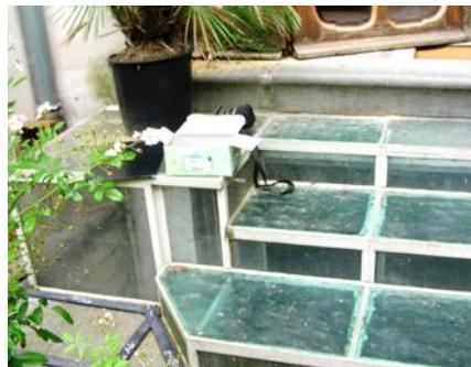
**FIG. 2.2** Victor Horta, Ancienne maison et atelier de Victor Horta, adaptation de l'escalier avant le remplacement du verre d'origine par un verre feuilleté conforme aux normes actuelles © Luc Reuse.
