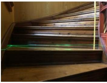
FIG. 8 The staircase's sinking © Dør og Vindusvern AS, 2019.
